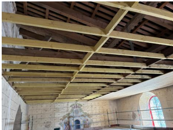
Remplacement intégral du lambourdage dans la chapelle avant la pose du plafond
