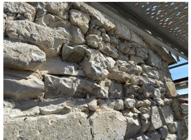
Après piquetage de l'enduit, les pierres les plus abîmées seront remplacées avant la reprise des joints
