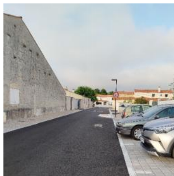
Le chemin des Fous : avant et après travaux
