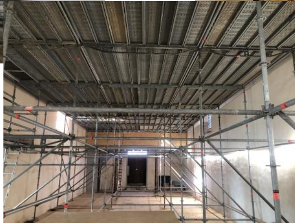
Remplacement intégral du lambourdage dans la chapelle avant la pose du plafond
