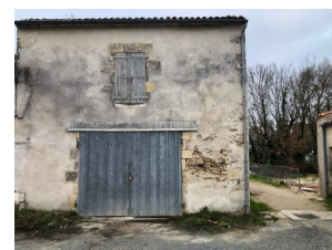
Au 1er plan le bâtiment à restaurer, à l'arrière-plan, la place laissée par celui qui a été démoli
